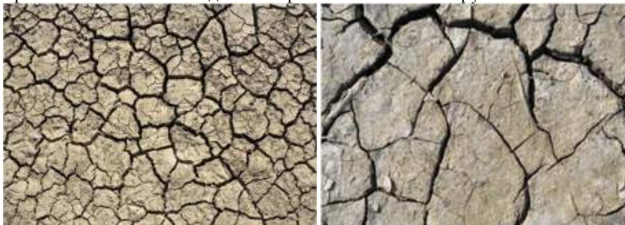
Рис. 8.18. Тріщини ґрунтового просідання.
