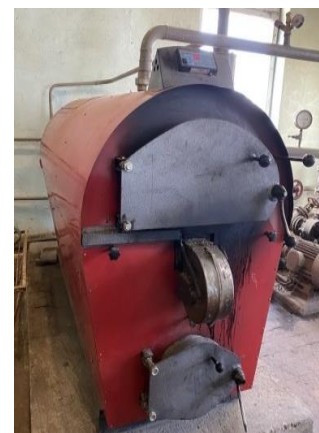
Рис. 6. Котли для спалювання біомаси енергетичних культур у Ялтушківській ДСС а. прямого спалювання б. газогенераторний для двофазного спалювання
