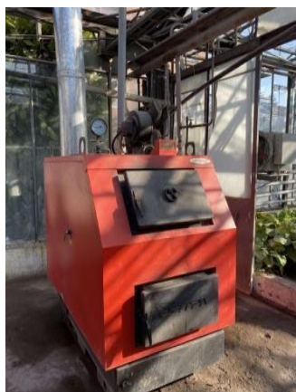
Рис. 6. Котли для спалювання біомаси енергетичних культур у Ялтушківській ДСС а. прямого спалювання б. газогенераторний для двофазного спалювання
