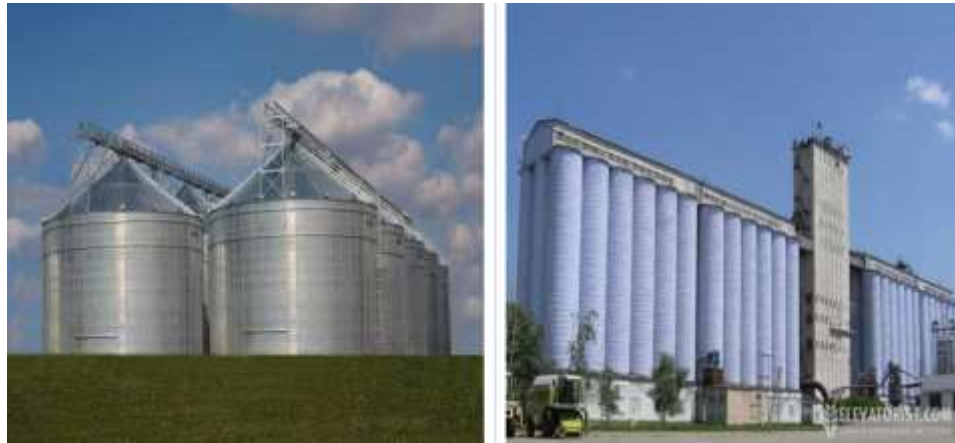
Рисунок 1.3. – Елеватори із залізобетонними і металевими силосами
